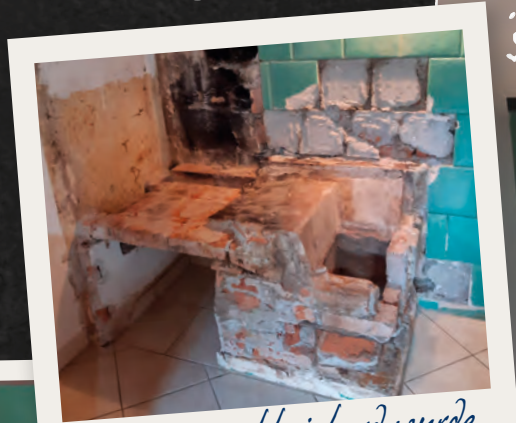
Der Durchheizherd wurde von Grund auf saniert.
