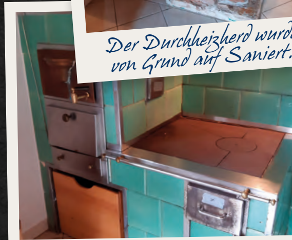
Sämtliche Metallteile wurden aufbereitet und wiederverwendet.
